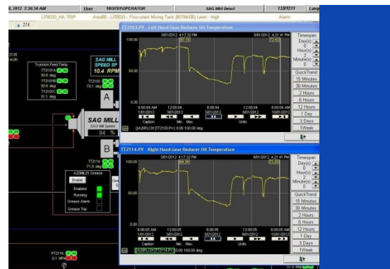
Temperaturas obtenidas del cuarto de control de 87° C y 84° C antes y de 72° C y 73° C después de la aplicación de Mobil SHC
